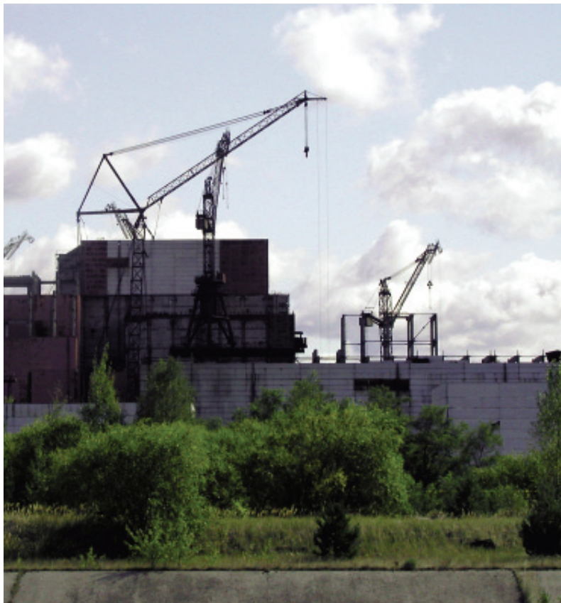
Byggkranarna står kvar runt reaktor nummer fyra. Efter olyckan byggdes en sarkofag för att stoppa ytterligare utsläpp men den är dålig och läcker. 2012 ska en ny sarkofag skjutas in över den gamla.
